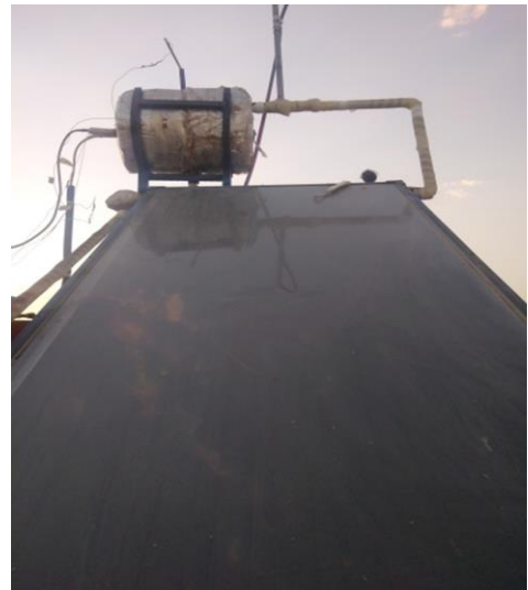
الشكل (1): المجمع الشمسي الحراري.
